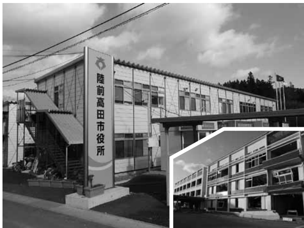
陸前高田市役所（左：現在、右下：津波被害を受けた旧施設）
